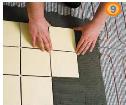
После полного высыхания плиточного клея **(НЕ МЕНЕЕ 7 ДНЕЙ!!!)**, подключите нагревательный мат и термодатчик к терморегулятору, а терморегулятор к сети.
