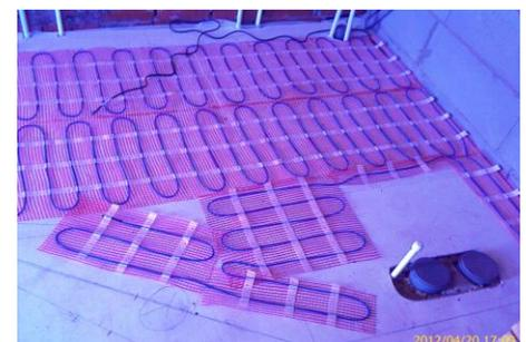
После того как термомат уложен, необходимо убедиться, что он не был поврежден в процессе монтажа, для этого необходимо замерить его омическое сопротивление или проверить на «разрыв» специальным прибором (мультиметром).
